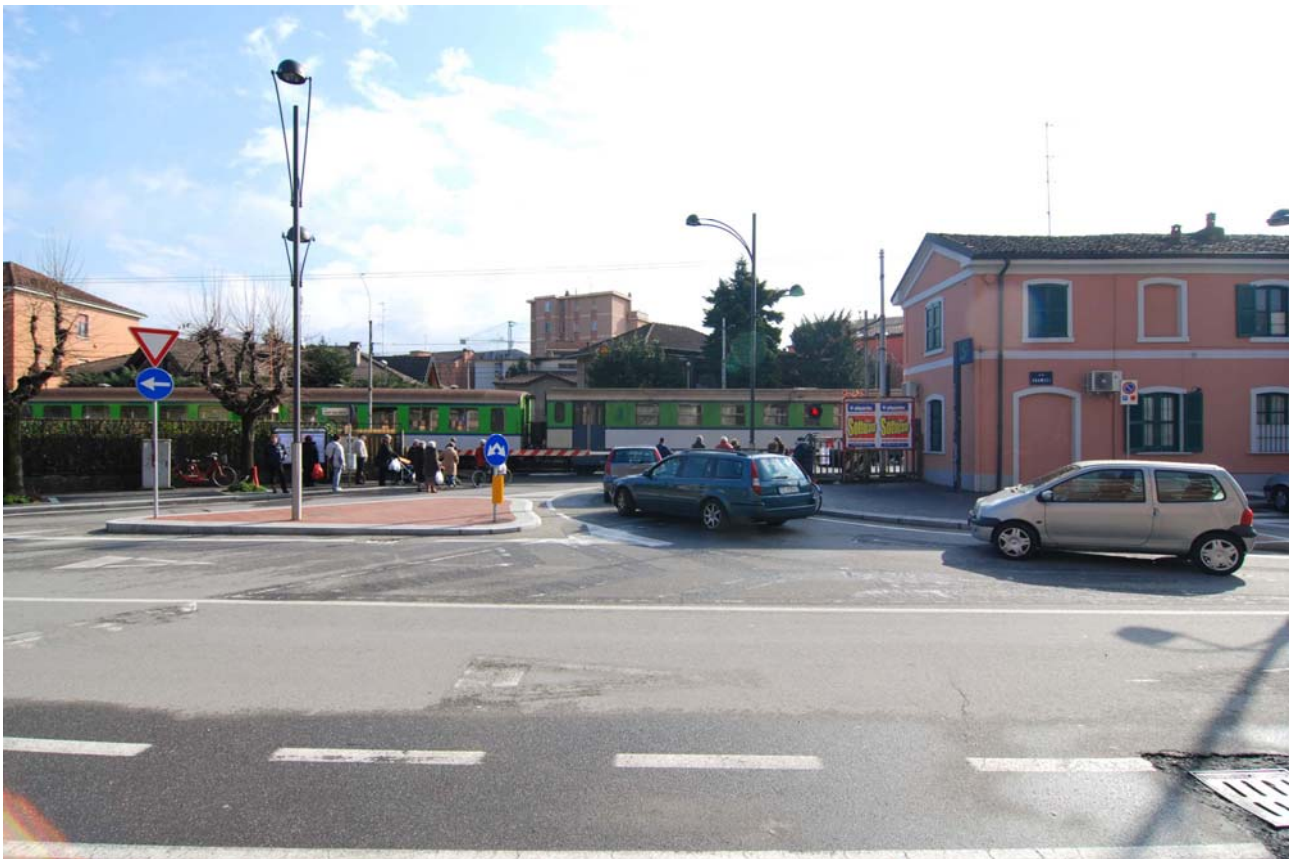
L'area antistante l'attuale stazione di Cormano e il passaggio a livello esistente
