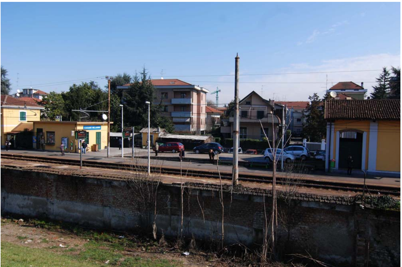
L'area dell'attuale stazione di Cusano Milanino vista dal rilevato a verde
