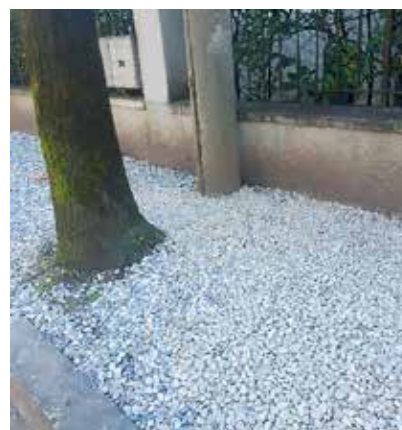
In progress, nei punti dove non ci si passa tra alberi e pali, Lavori in corso
