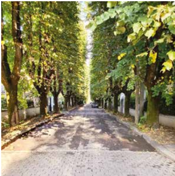
- L'originario aspetto della strada, con manto compromesso e cordoli disconnessi. I piccoli marciapiedi non permettono il passaggio di carrozzine e in alcuni tratti nemmeno di un pedone.
